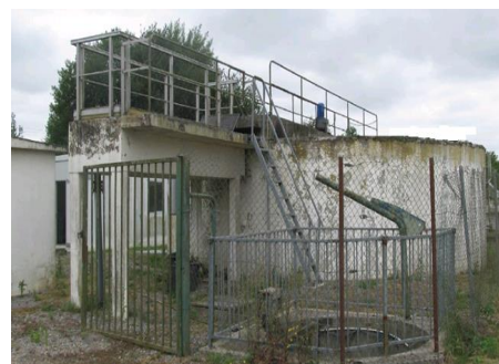
Station de traitement Wassigny 1200 EH.
