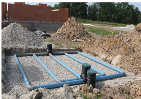
Installation assainissement non collectif
