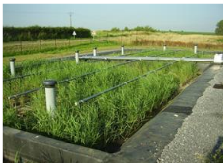
Station de traitement Proisy 600 EH.
